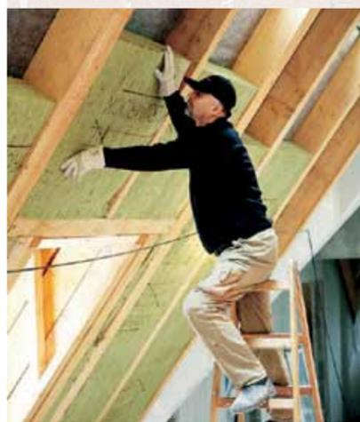
**Dachdämmung** kann für enorme **Energie-Einsparung** sorgen.
