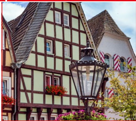
Die Straßenbeleuchtung in der VG Linz soll sukzessive saniert werden. Bild: Comofoto
